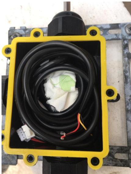
Figura 6.4-1. Caixa de connexions després de la prova d'estanquitat.
