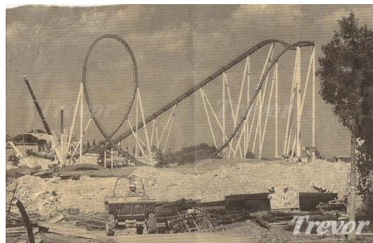
Dragon Khan en construcció
