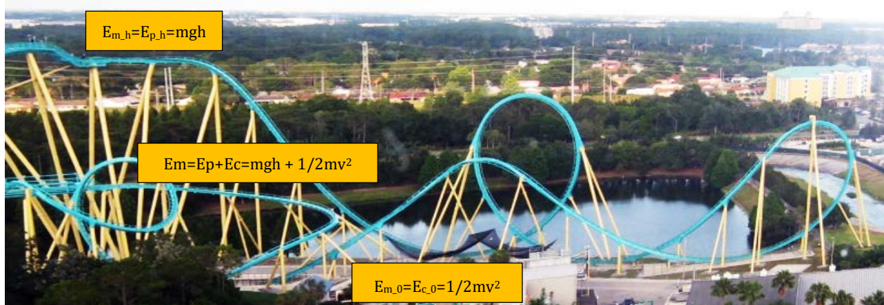
Energia mecànica al llarg del recorregut d'una muntanya russa
