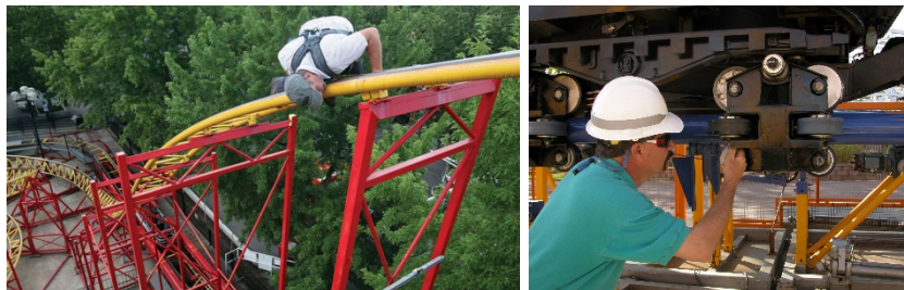
Treballs d’inspecció de les muntanyes russes
