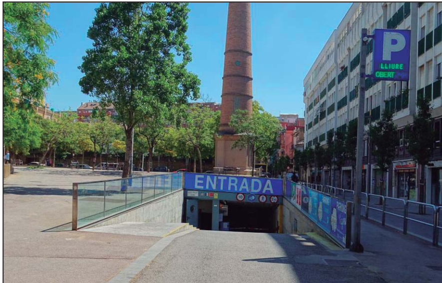
Entrada del pàrquing (fotografia pròpia)
