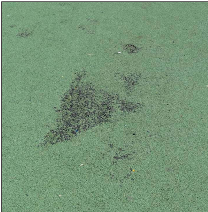
Terra parc infantil deteriorat
