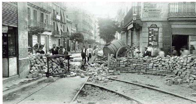
Fig. 4.1.1 PAVIMENTACIÓ D'UN CARRER AMB LLAMBORDES DE PEDRA
