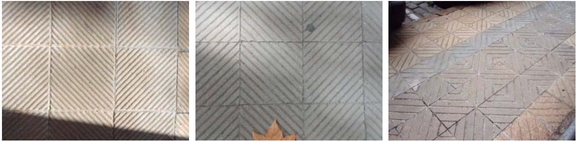
Fig. 5.10.3 PANOT 20, 13 i 5 BANDES DIAGONALS. Respectivament C. Pau Gargallo i Estació Sagrera. Fotos: A. Rosell i Miquel
