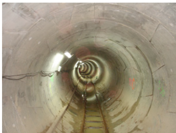
Túnel revestit de dovelles
