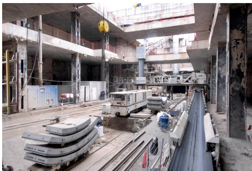
Obres al Tram 1 de la L9 de Barcelona
