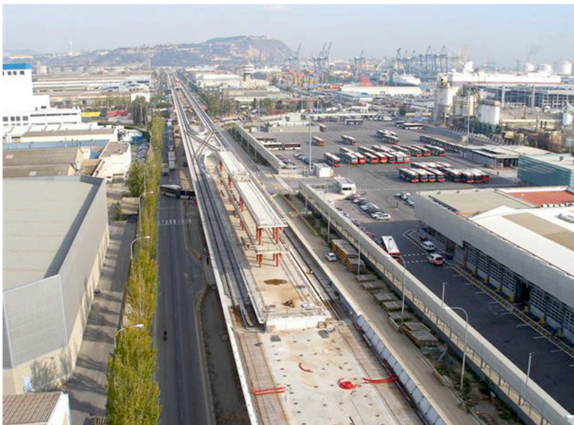
Foto aèria del viaducte de la Zona Franca, L9
