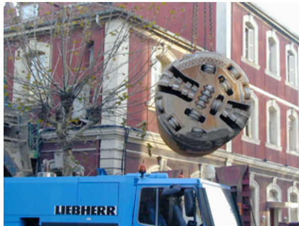
Tuneladora d'escut tancat hidroescut
