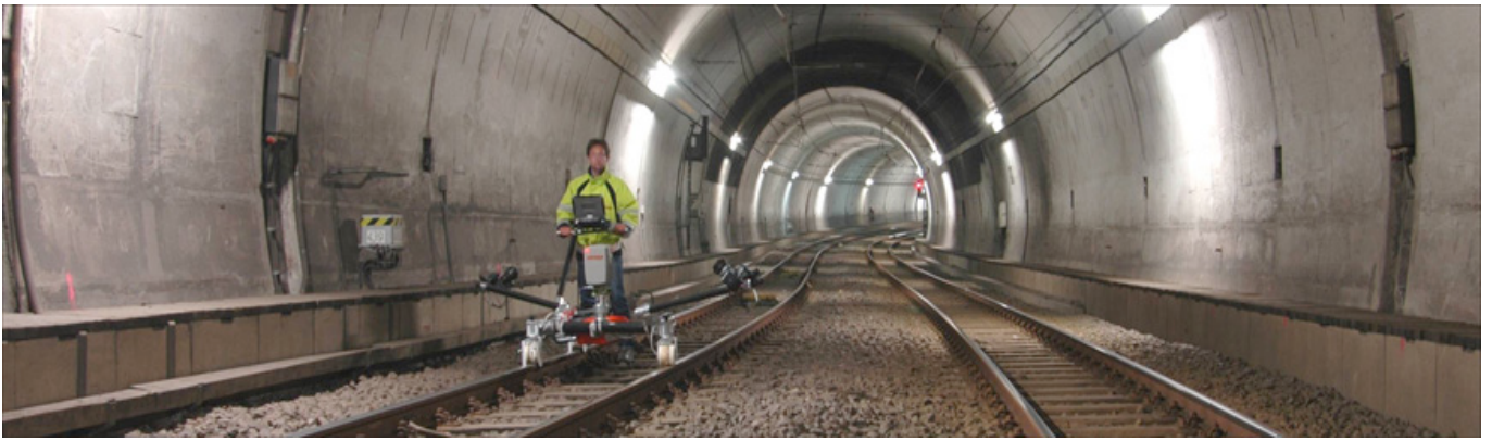
Auscultació dels túnels
