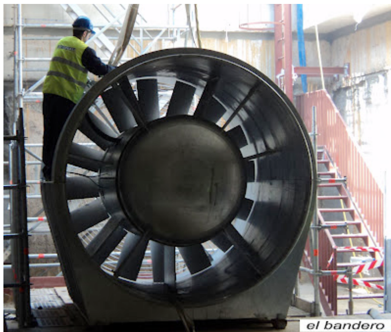
Instal·lació de ventiladors a la L9 de Barcelona
