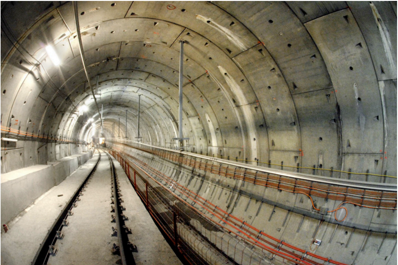
Túnel Tram 4 L9 de Barcelona
