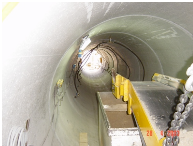
Túnel construït per penetració de tubs
