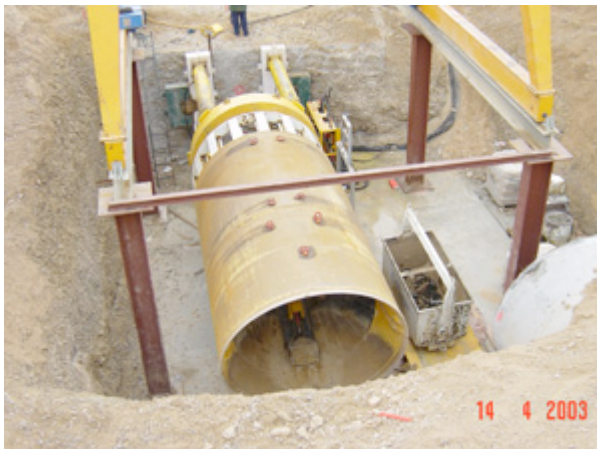
Tuneladora d'escut obert
