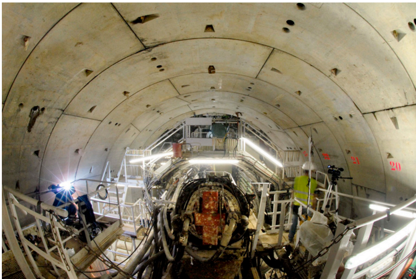
Pas de la tuneladora al Tram 1 a la L9 de Barcelona
