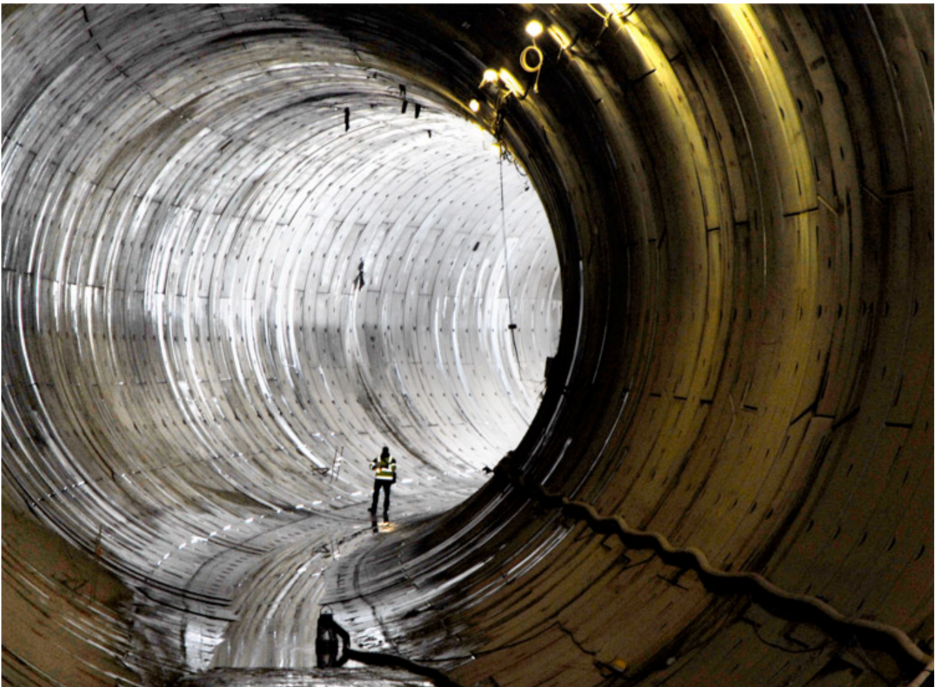
Túnel Tram 4 de la L9 de Barcelona
