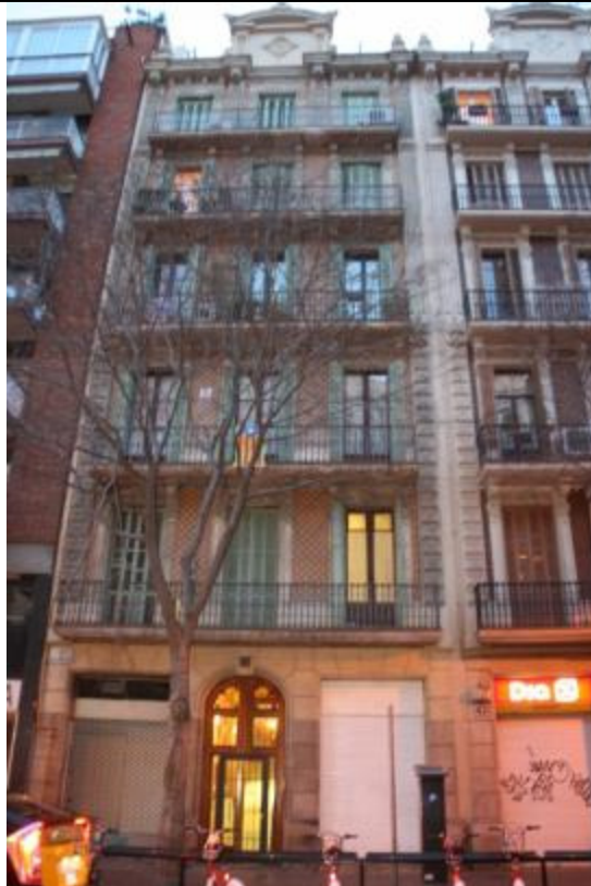
FIGURA 37 Vista actual de l'edifici on hi havia la fàbrica Val Menéndez
