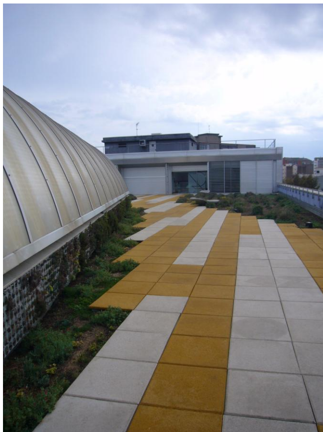
Figura 14: Teulada de l'edifici d'oficines del carrer Avila 138 al 22@ Barcelona vista 1
