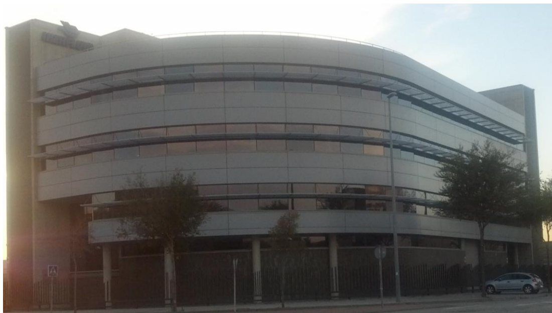
Figura 62: Edifici d'oficines c/Botànica encreuant amb Miguel Hernández Hospitalet de Llobregat.
