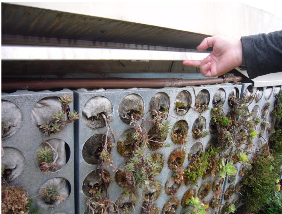
Figura 16: Teulada de l'edifici d'oficines del carrer Avila 138 al 22@ Barcelona vista 3
