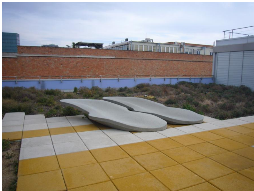
Figura 15: Teulada de l'edifici d'oficines del carrer Avila 138 al 22@ Barcelona vista 2
