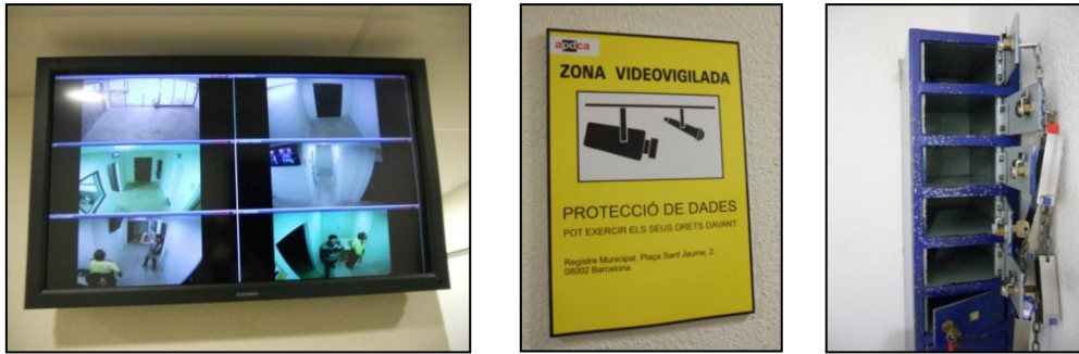
Figures 25, 26 i 27. Detalls del nou sistema de videovigilància i l'armé per a que els agents es desarmen abans d'entrar els detinguts a les cel·les.
