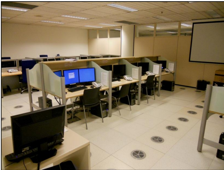
Fig 20. La sala Backup del CGE, a punt per si cal fer-la servir.
