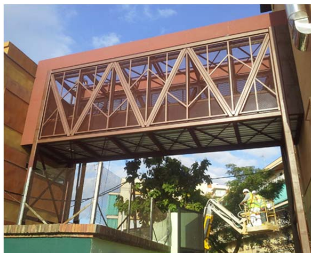
Institut escola Escola Roquetes: connexió entre edificis
