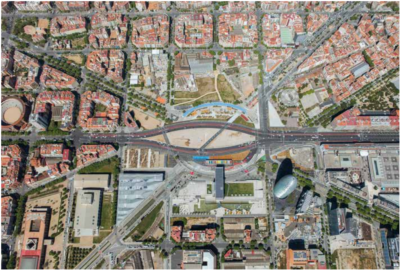
Imatge aèria de l'àmbit de les Glòries
